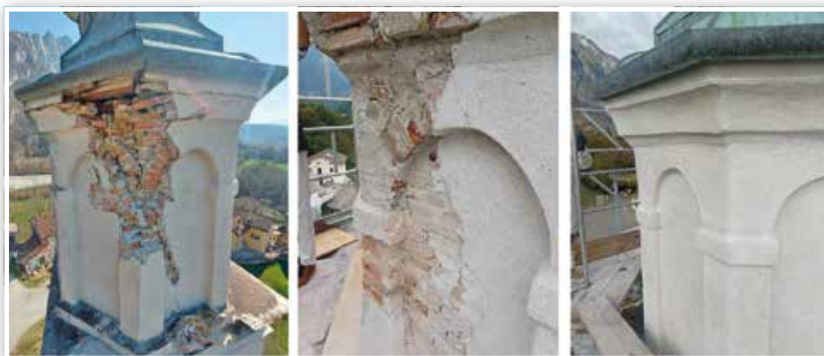
Foto 5: il restauro della porzione di tamburo distrutta dal fulmine: prima, durante e dopo l'intervento.
