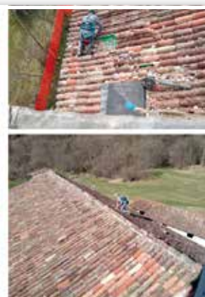
Foto 3: manto della chiesa colpito e frantumato dagli elementi caduti dal campanile; fasi di lavorazione e finale.
