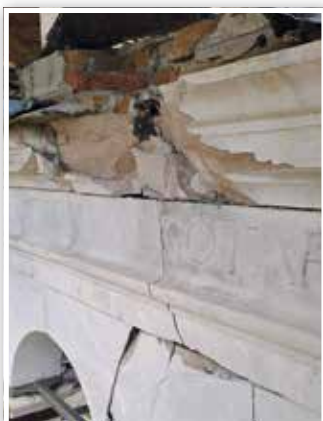
Foto 2: il cornicione lapideo con parti della pietra frantumate e spostate.
