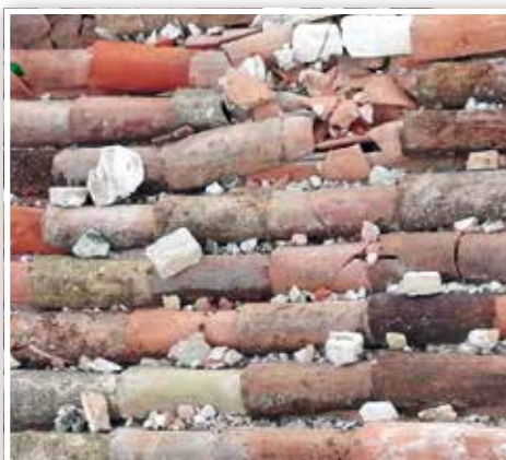
Foto 3: manto della chiesa colpito e frantumato dagli elementi caduti dal campanile; fasi di lavorazione e finale.
